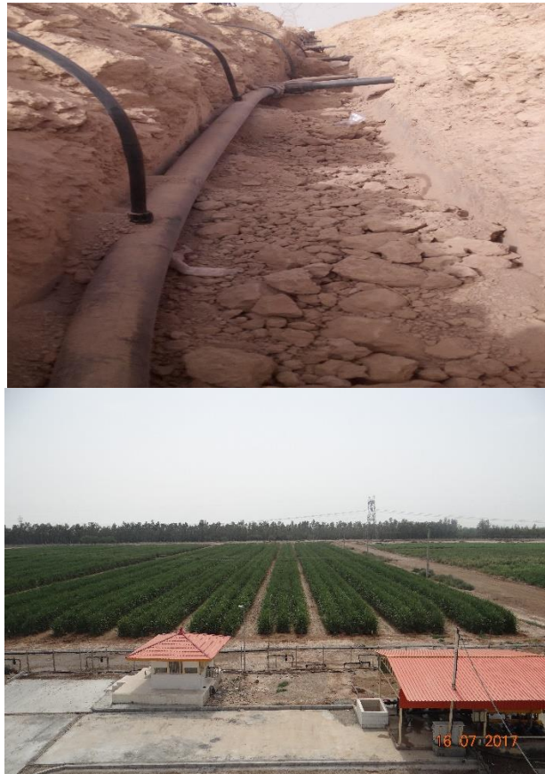
شکل ۲- بخشی از مزرعه آزمایشی و نحوه اتصال لوله آبده به مانیفولد در سامانه آبیاری قطره‌ای زیرسطحی
